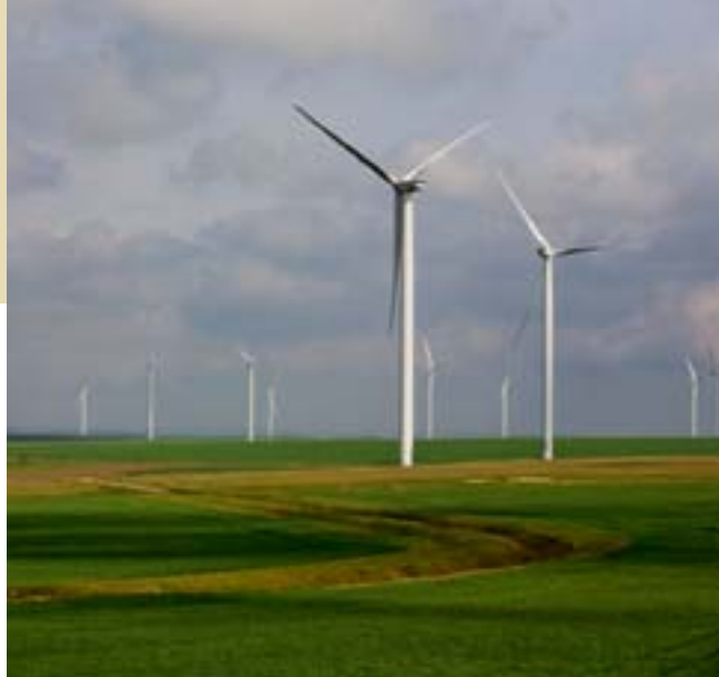
Fântânele wind farm © CEZ
