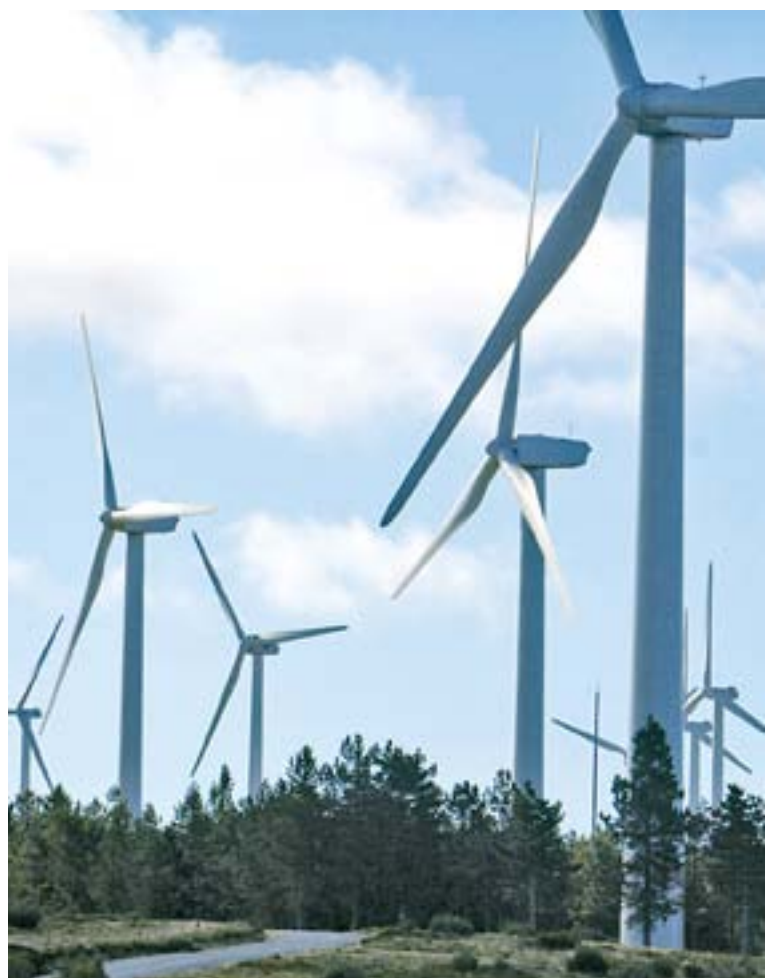
Lomba da Seixa wind farm © Nordex Energy
