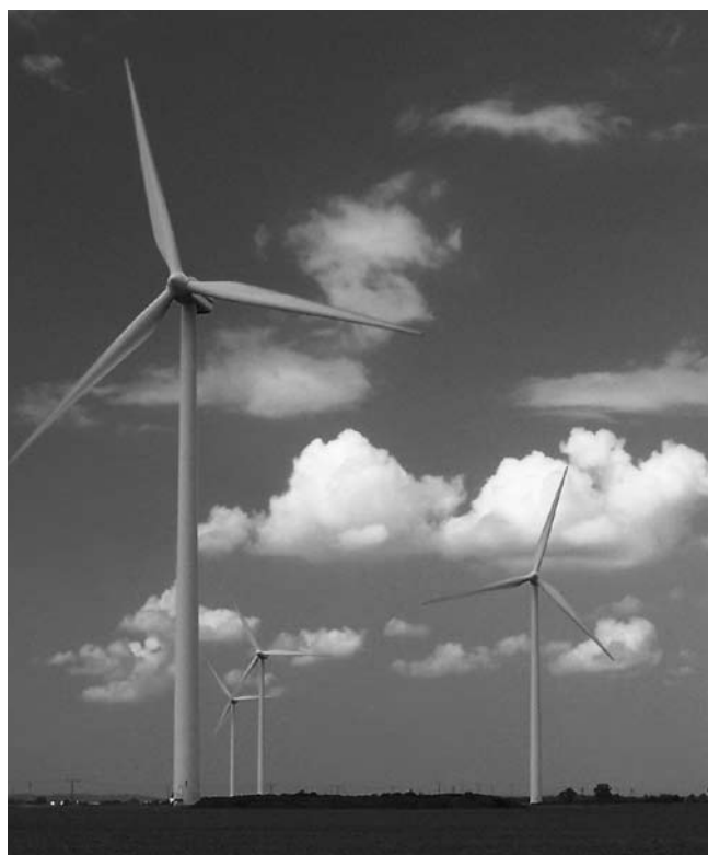
Zagórze wind farm @PWEA
