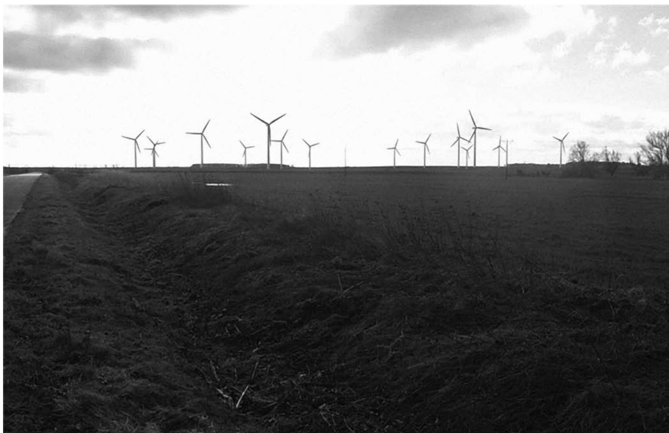
Zagórze wind farm @PWEA
